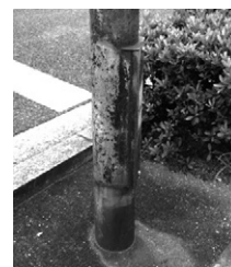
腐食した水銀灯
